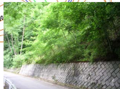
P-2 道路擁壁状況 擁壁や路面に変状は認められない。
