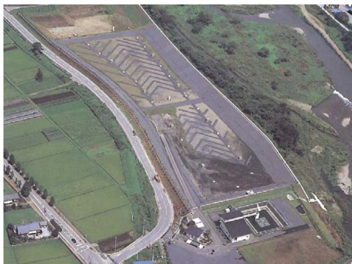
栃木県鹿沼市 埋立容量 : 112,000m 3
