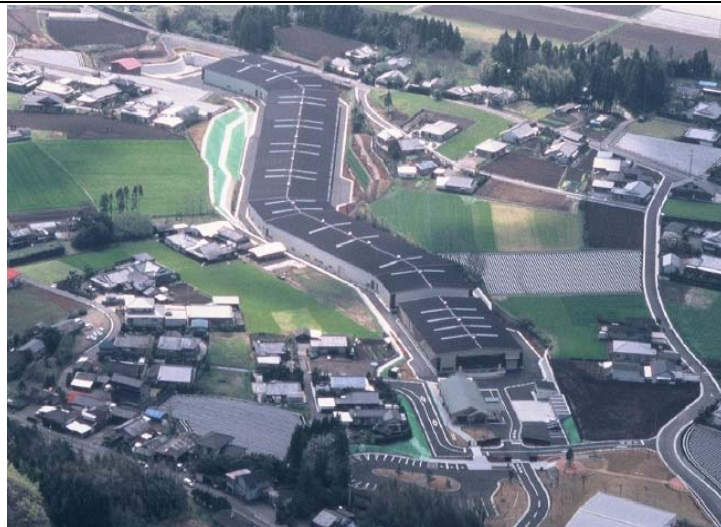
宮崎県都城市 埋立容量：77,700m 3
